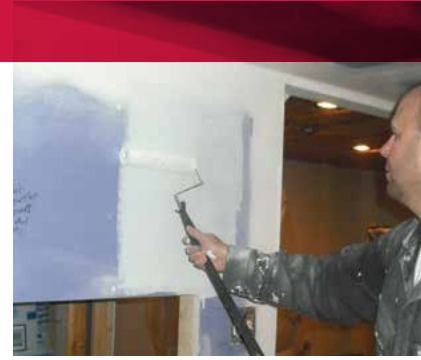
Applying primer to new drywall.
